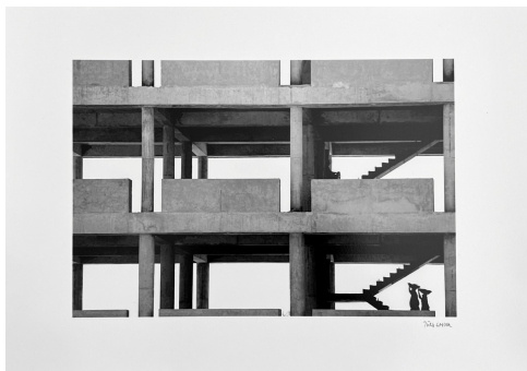
Jürg Gasser Bauarbeiten an einem Bürogebäude (City Center) Chandigarh, 1968 / 2026
